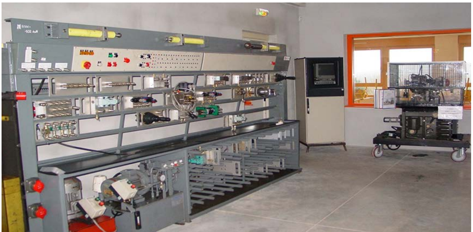
Vue partielle de la zone hydraulique, en arrière plan une salle de cours attenante qui nous permet d'alterner les parties théoriques et pratiques pendant les séances
